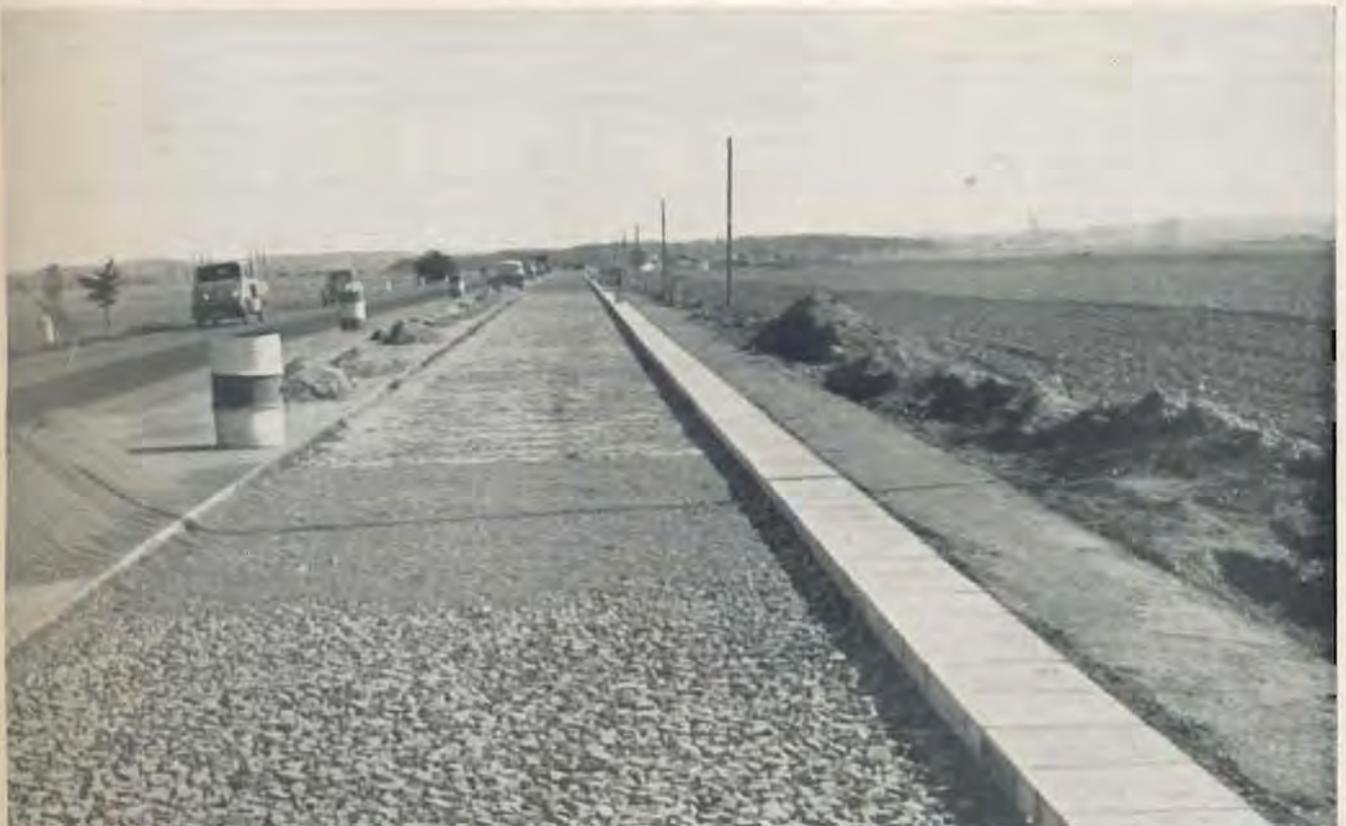
Abb. 1: Abschnitt der Unterbau-Versuchsstrecke mit Schotterunterbau — Im Hintergrund: mit Sand eingerüttelt, im Vordergrund: mit Splitt eingerüttelt
