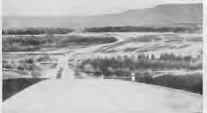
Abb. 1. Autobahn mit unruhig angeordneten Kurven mit dem Ergebnis, daß Teile der Straße unsichtbar werden
