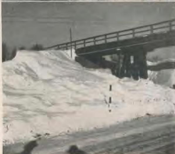
Bild 1: Schneeablagerungen im „leeseitigen Dreieck“ hinter einem Schneezaun
