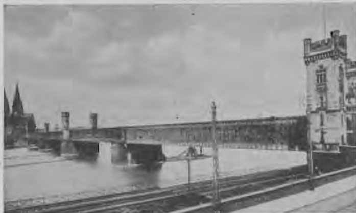
Abb. 1. Alte Dombrücke (Gitterbrücke).
