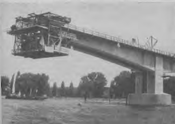
Bild 2. Rechter Stropfpfeiler und Kragarm der Mittellöffnung
