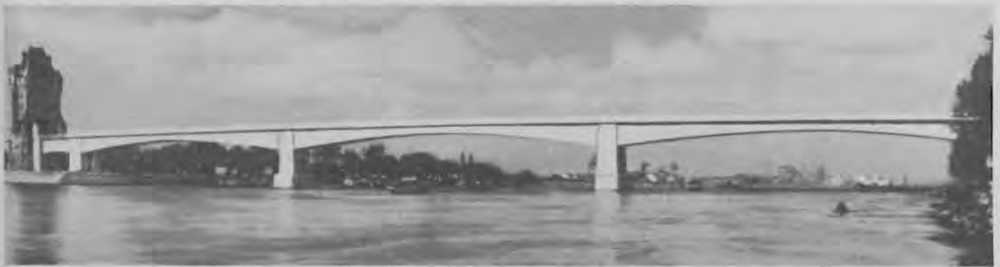
Bild 3. Die fertige Brücke.
