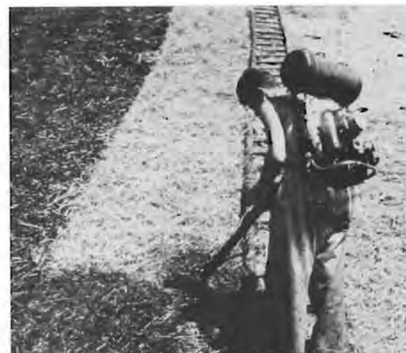
10 Besprühen der Stroheckschicht mit Bitumen-Wasser-Emulsion mittels Kleinsprühgerät.
