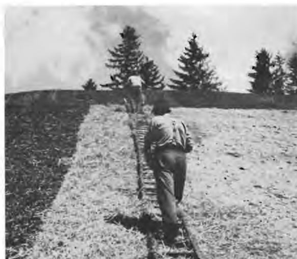
9 Beriesung durch Saat auf Stroheckschicht: Saat und Düngung auf die frisch ausgelegte Strohschicht von Hangleitern aus. Rechts kahler Rohboden, links bereits mit Bitumen befestigte Strohschicht.
