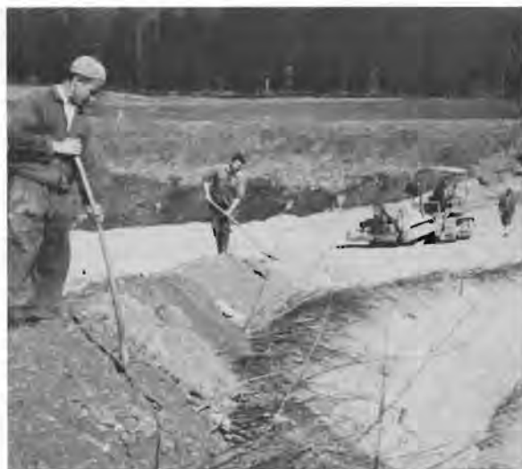
8 Maschinelles Zuschütten und Verdichten.
