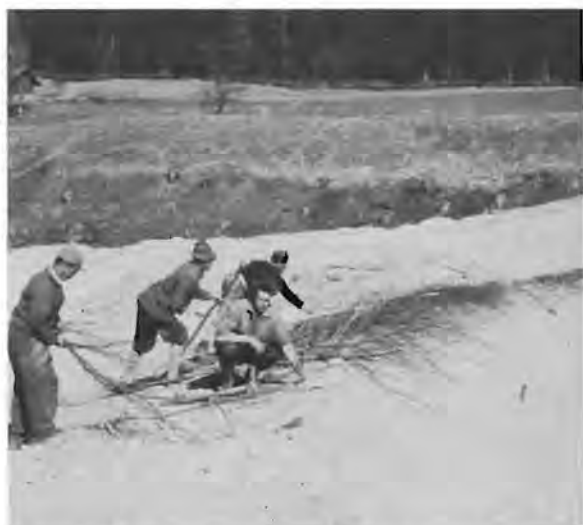
7 Bau gemischter Buschlagen während der Schüttung: Auslegen des Buschwerkes.
