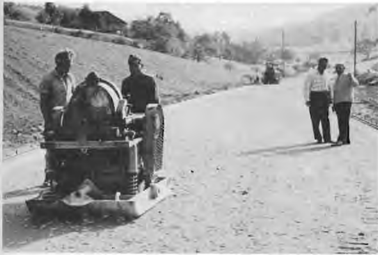
Abb. 9 und 10: Verdichten der Tragschicht mittels schwerer Flächenrüttler.
