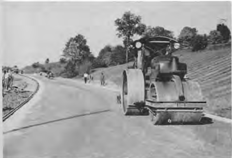
Abb. 11, Glätten der Tragschicht mittels schwerer Glatzwalze.
