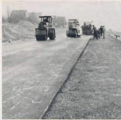
Abb. 24. Einbau der Tragschicht aus Bitumenkiessand
