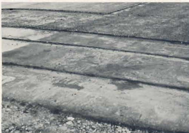
Abb. 26. Ansicht der einzelnen Einbaulagen der Gesamtbefestigung
