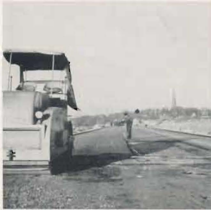
Abb. 23. Einbau der Tragschicht aus Bitumenkiessand
