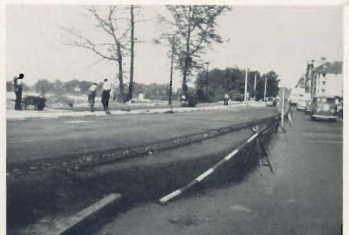
Abb. 27. Ausgleich mit Heißbitumensand bei vorhandenem Betonunterbau
