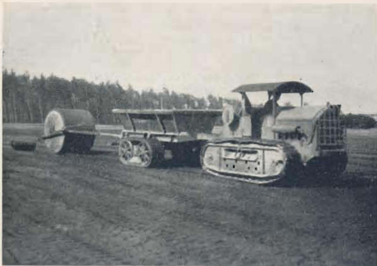
Abb. 3: Nachverdichten der bituminösen Vermörtelung
