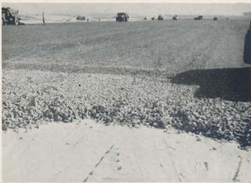
Abb. 4: Zweischichtiger Schotter-Unterbau der neuen Startbahn, 30 cm stark Flughafen Newark N. J.
