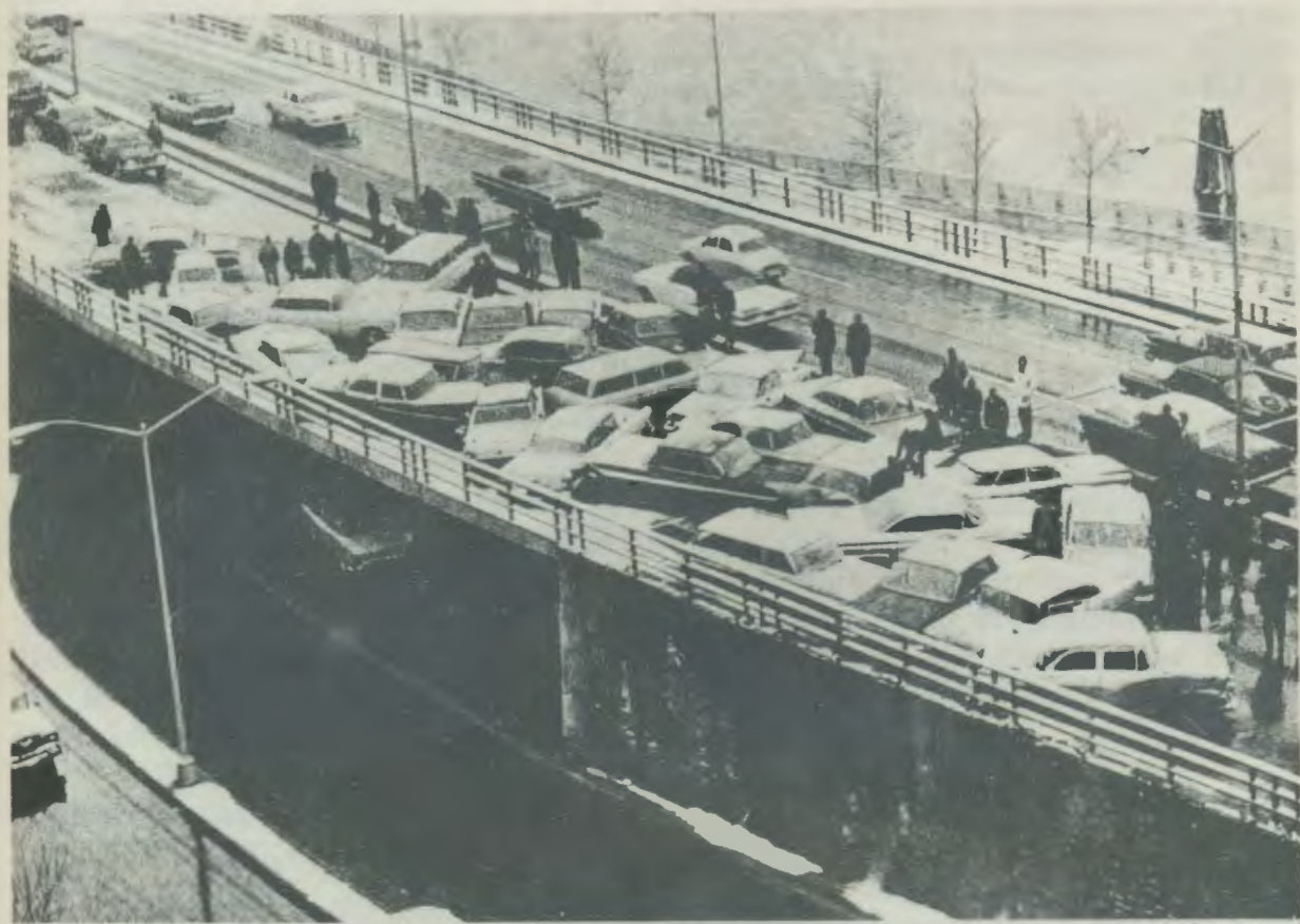
Abb. 117 Massenkarambolage infolge Glättebildung auf unterkühlter Autobahnbrücke.
